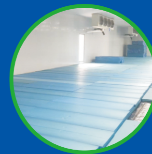
冷库挤塑板施工现场(3)
