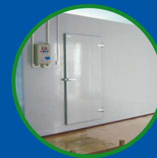
冷库挤塑板施工现场(4)
