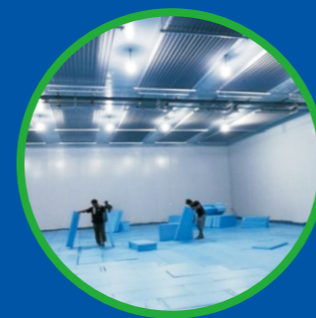
冷库挤塑板施工现场(1)
